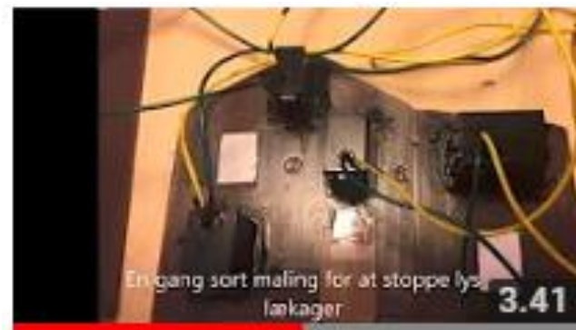
Husbyggeren i Kælderkøbing
